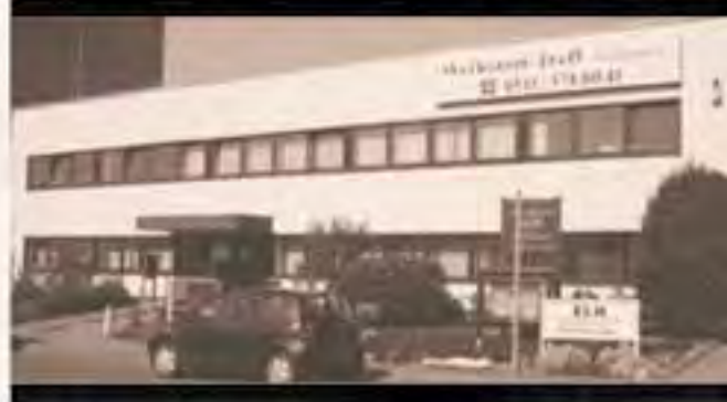
Das Verwaltungsgebäude in der Bogenstr. 4c
